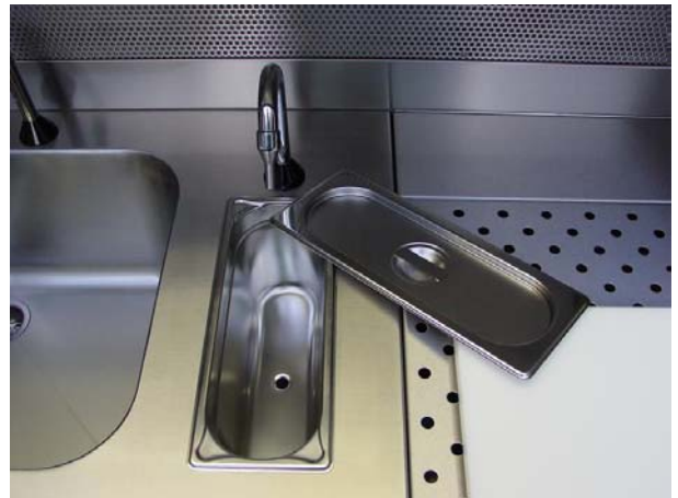
Pileta y dispensador de formol
